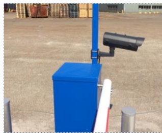
▲ opstelling met ALPR systeem
